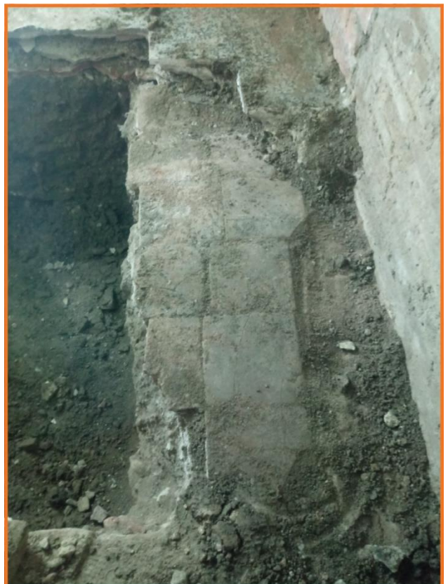
Foto 2. Desmuntatge del paviment de maons original de l'edifici UE 4.
