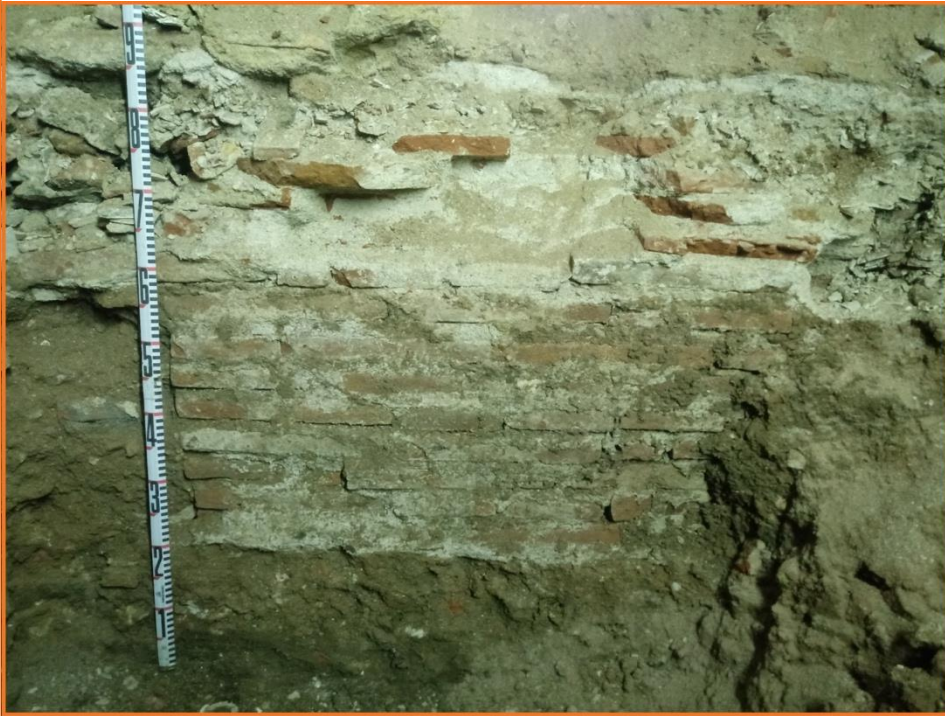
Foto 7. Fonament de l'edifici actual usat com a reforç de l'escala.
